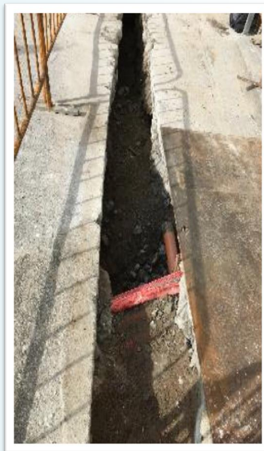
GABIA PARA NOVA CANALIZACIÓN
